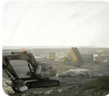
Waste Landfill Enclosure
